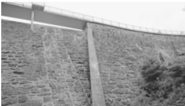
Das Kraftwerk Chapfensee-Plons erzeugt seit dem Jahr 1948 elektrische Energie.
