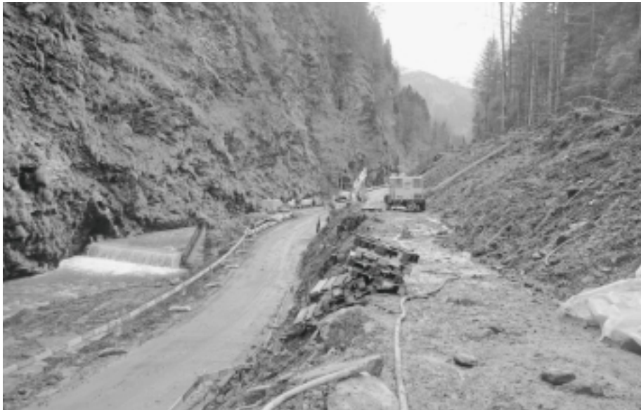
Die Bauarbeiten im Samichlaus sind im Gange.
