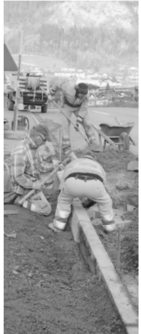
Die Arbeiten am Gabreitenweg konnten vor Wintereinbruch beendet werden.
