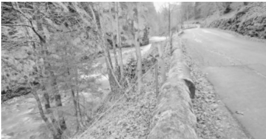
Der Strassenabschnitt Esel-Samichlaus wird saniert
