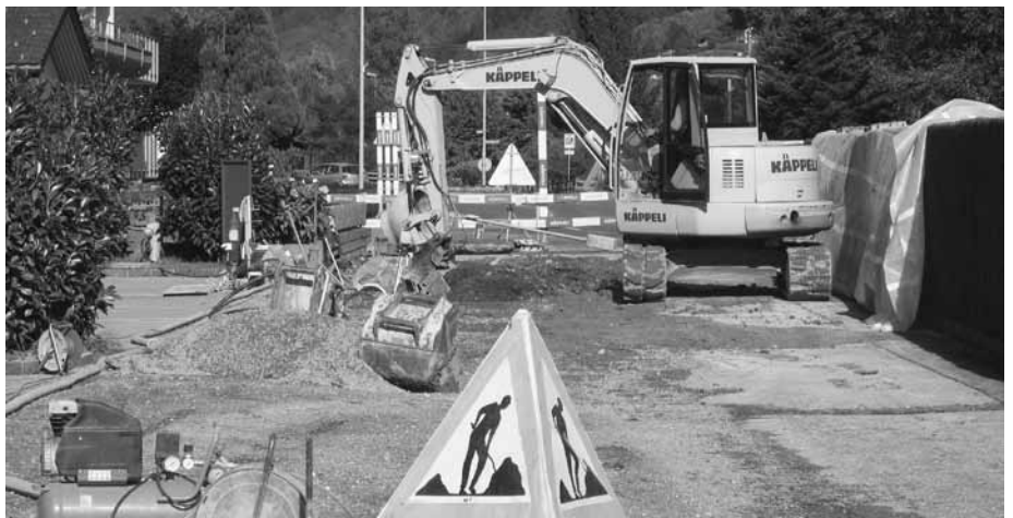
Die Bauarbeiten am Kinoweg schreiten voran.
