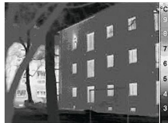
Wärmebild eines sanierten und unsanierten Hauses im Vergleich
