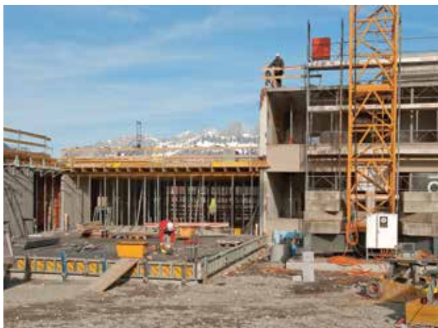
Nach der überwältigenden Zustimmung zum Schulhaus Heiligkreuz begannen schon im Sommer die Bauarbeiten. Diese kamen 2012 plangemäss voran.
