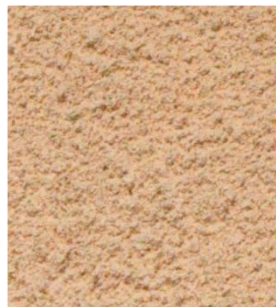
Ortsbildschutzgebiete 1 / 2: Fassaden verputzt
