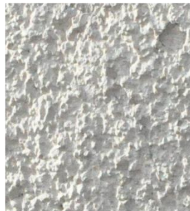
Ortsbildschutzgebiete 1 / 2: Fassaden verputzt
