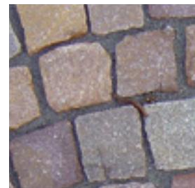
Pflästerungen aus Naturstein Kernporphyr, Fugen mit Zement ausgegossen. Randabschlüsse zu Strasse mit Granit.
