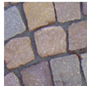
Pflästerungen aus Naturstein Kernporphyr. Im Grundsatz sind die Fugen offen mit Sand / Splitt gefüllt und nur in Ausnahmen mit Zement ausgegossen.
