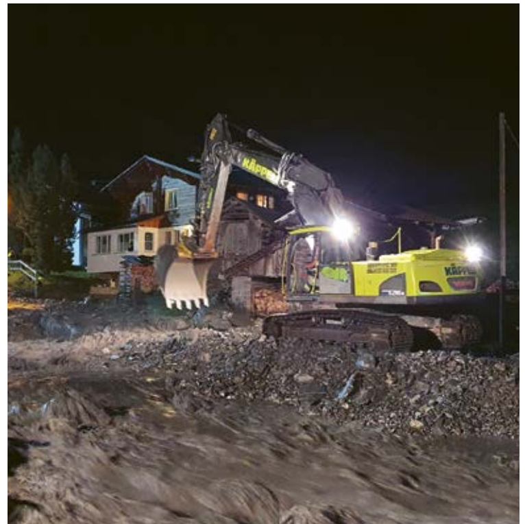
Soforthelfer vor Ort: Ohne den umgehenden Einsatz von schwerem Gerät wäre dem Gefulbach nicht beizukommen gewesen.
