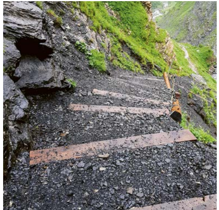
Zivilschützer im Einsatz: Der zerstörte Foopassweg nach seiner Instandstellung.
