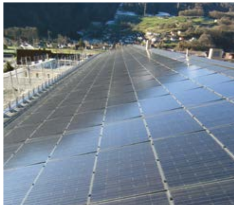
Beispiel: Solaranlage Schulhaus Heiligkreuz
