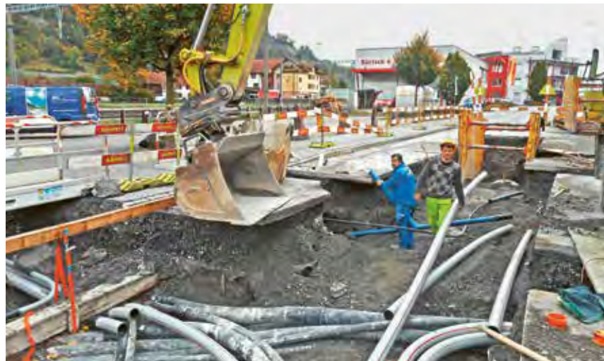
Ein Projekt von einem Kilometer Länge: Die Baustelle in der Ringstrasse (ganz links), in der Grofstrasse (links) und schliesslich an der neuen Kreuzung an der Sarganserstrasse.
