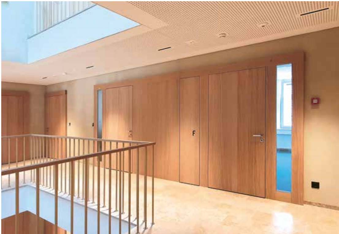
Flecken an der Rathausenerweiterung: Mit den Beteiligten konnte eine Lösung gefunden werden. Die Fassade (linkes Bild) erhält einen Anstrich.
