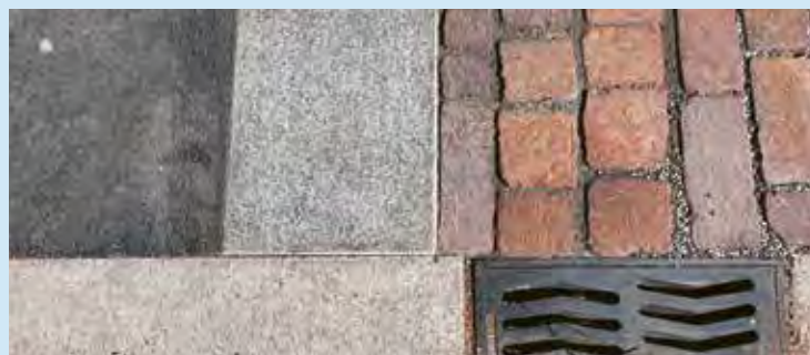
Materialisierung: Teerbelag bei kleinen Vorplätzen vor den Gebäuden, Porphyr-Pflästerung (bewusst wie bisher, rötlicher Stein, der Atmosphäre verleiht) für Vorplätze mit Umrandungen und Wasserrinnen aus Granit.
