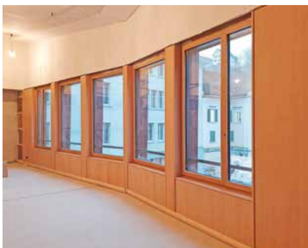
Angenehme Atmosphäre: Die Holzverkleidung gibt den lichtdurchfluteten Räumen im Verrucano Wärme.
