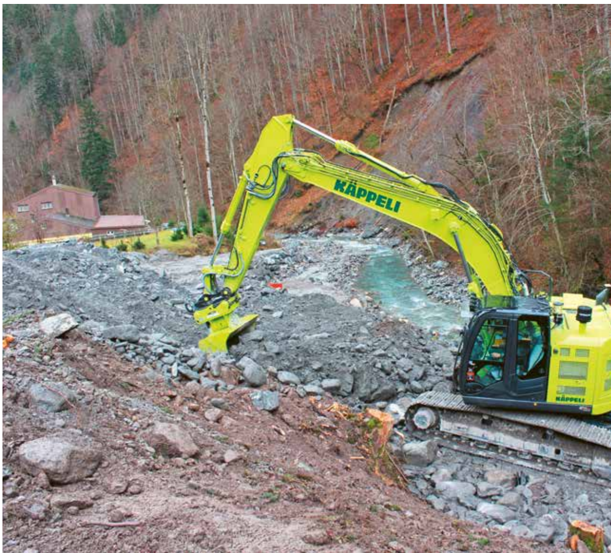
Neue Strassenlinienführung: Der Aufbau wird mit Material aus dem Weisstantal, welches beispielsweise in Absprache mit den kantonalen Ämtern den Bächen entnommen wurde, realisiert.
