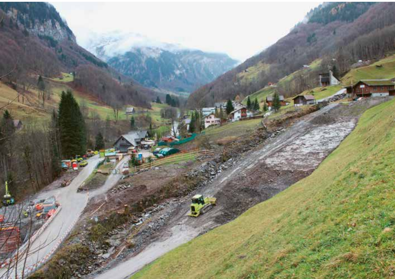
Es tut sich einiges auf der Baustelle «Mülibach»: Ein neuer Bachlauf entsteht und die Weisstannerstrasse erhält eine neue Brücke. Dabei wird möglichst wenig Material herangeführt, sondern vorwiegend das vor Ort vorhandene Material verwendet.
