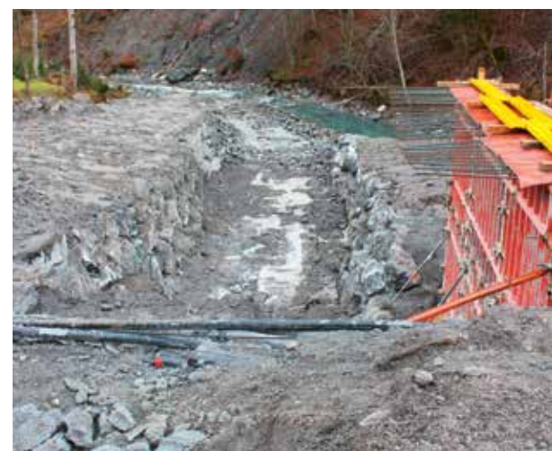
Neuer Bachlauf: Bei der Forellenzucht wird der Mülbach in Zukunft in einem neuen, mit Steinen ausgelegten Bett in die Seez geführt.
