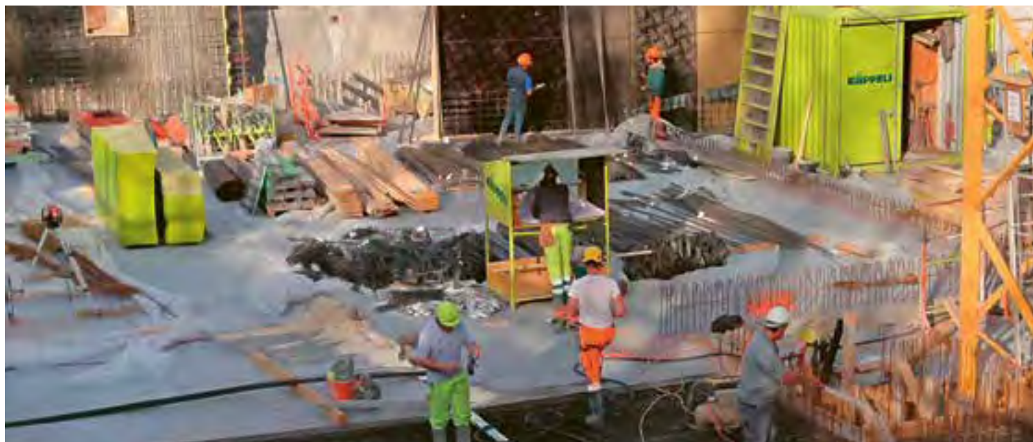
Es wird gebaut: Baustelle Melsershof.
