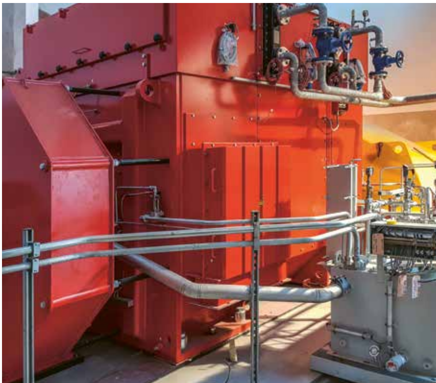
Das Innenleben des Kraftwerks Plons vor der Inbetriebsetzung (oben) und das Kraftwerk Weissenstein (rechts) bei der Inbetriebnahme.
