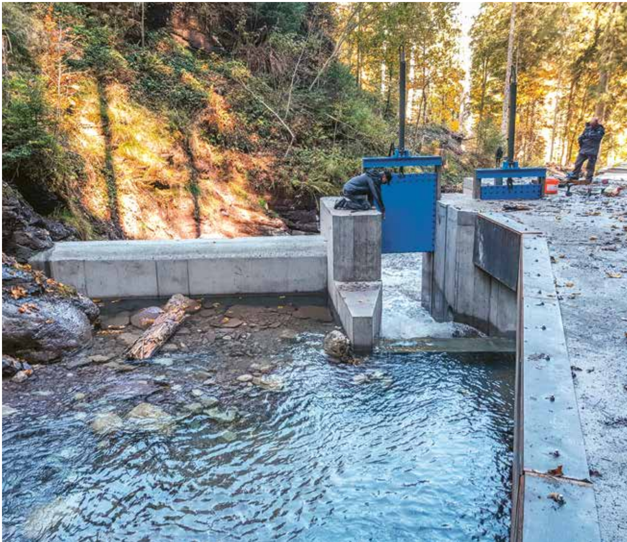
Feinjustierung: Die neu erstellte Wasserfassung Chotschlagbach im Weissenstein.
