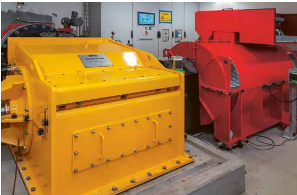
Schon in Betrieb genommen: Im Kraftwerk Chapfensee (links) wird bereits seit November Strom produziert. Oben eine zweidüsige Pelton-Turbine im KW Plons.
