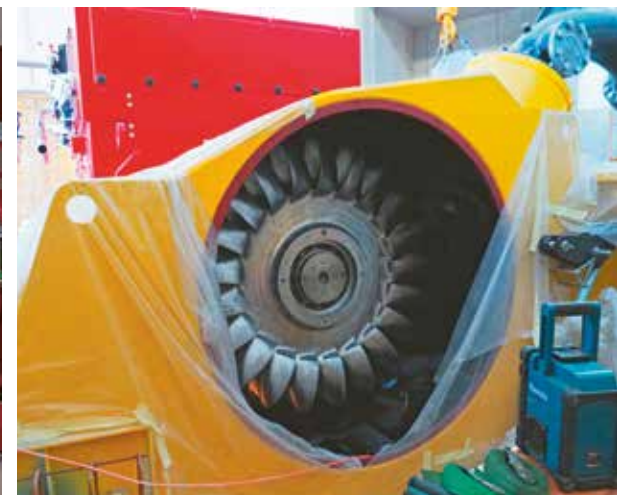
Schon in Betrieb genommen: Im Kraftwerk Chapfensee (links) wird bereits seit November Strom produziert. Oben eine zweidüsige Pelton-Turbine im KW Plons.
