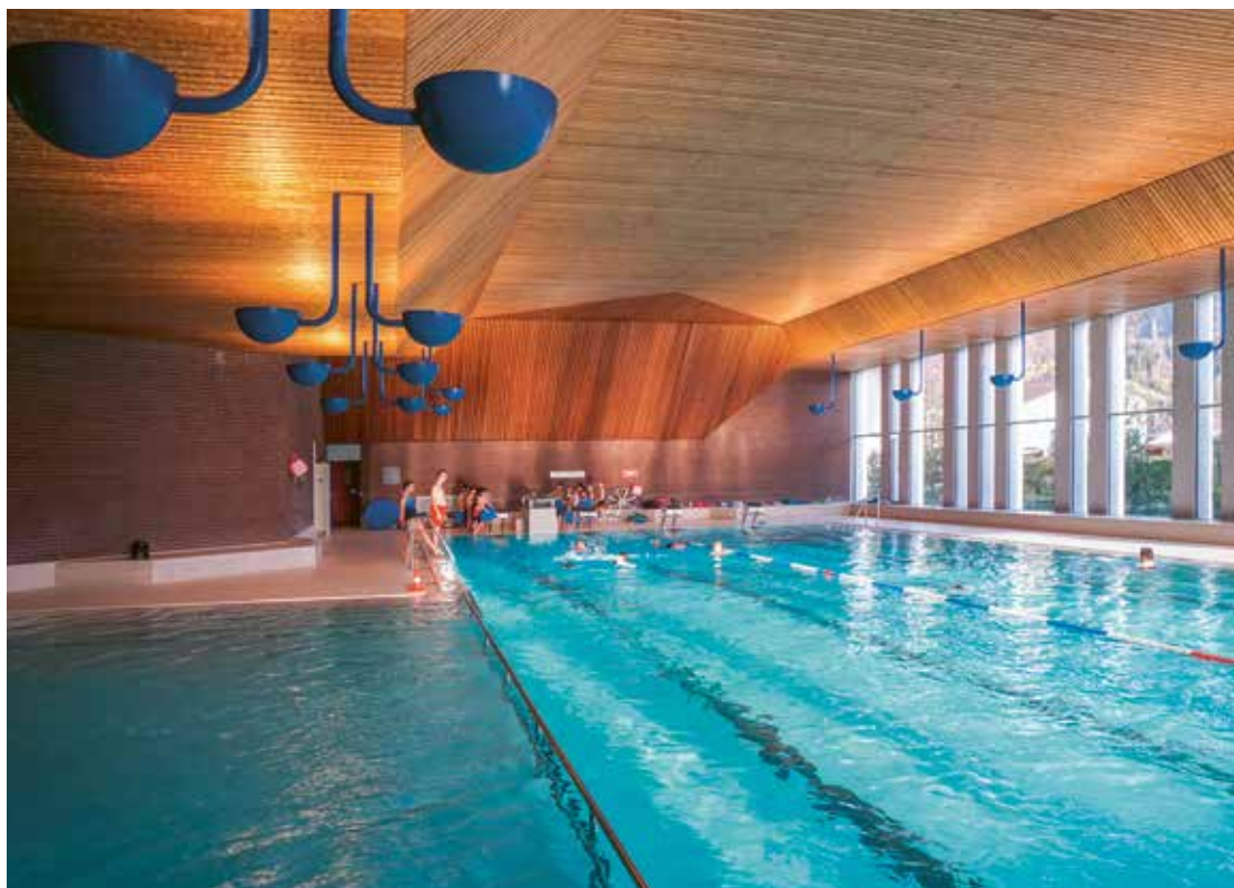
Atmosphäre bewahrt, Stromverbrauch reduziert: Die Umstellung auf LED ist rundum gelungen.
