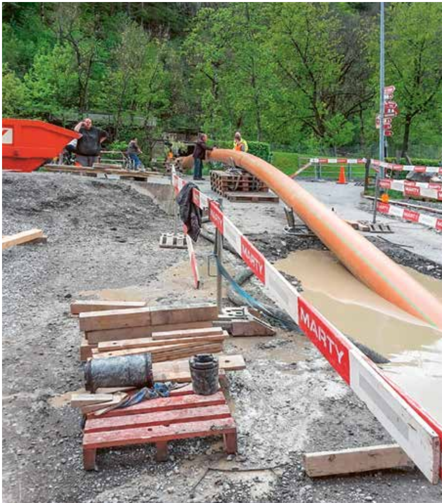
Neuer Versuch im Frühjahr 2019: Sollte die Spülbohrung wieder nicht erfolgreich sein, würde die Leitung in einem Graben verlegt.
