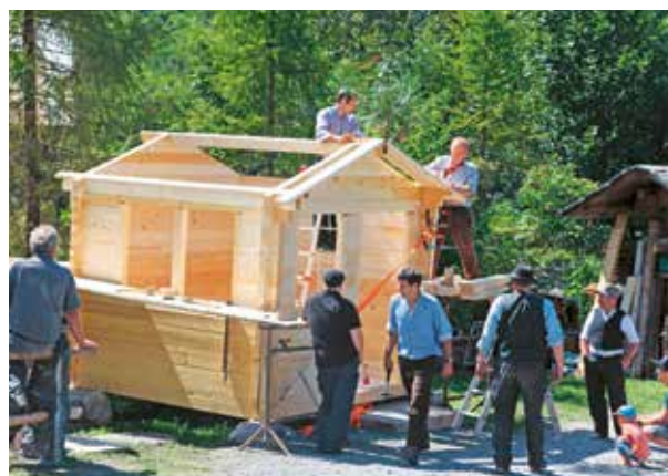
Fachleute machen es vor: In Rekordzeit entsteht ein Hüttchen, das für das Trocknen von Kräutern verwendet werden soll.
