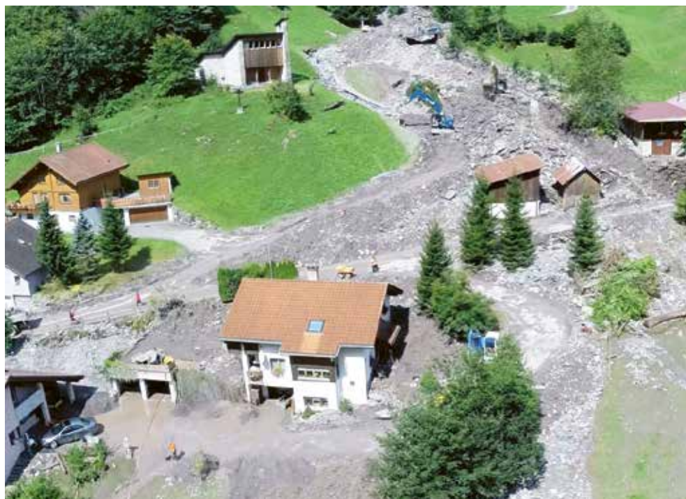
Kein Baustart in Sicht: Im Bild Aufräumarbeiten, nachdem der Mülibach sein Bett verlassen hat.
