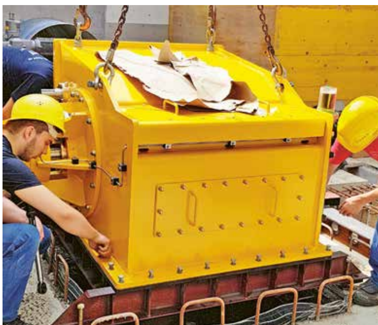
Die Arbeiten schreiten voran: Links eine Durchströmturbine, während rechts die letzten Meter der Druckleitung zum KW Plons verlegt werden.
