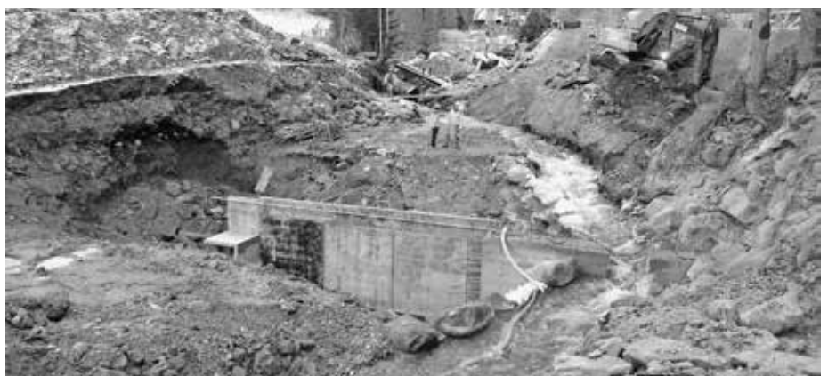
Seezsanierung: Die neue Sperre im Gebiet Schafgaden nimmt Gestalt an.
