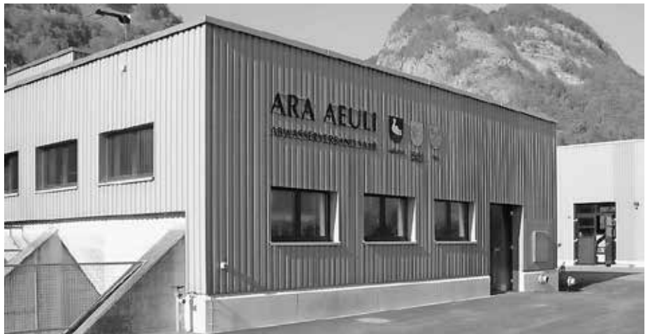
Abwasserverband Saar: In der ARA Aeuli wird rund ein Fünftel des Melsers Abwassers gereinigt.
