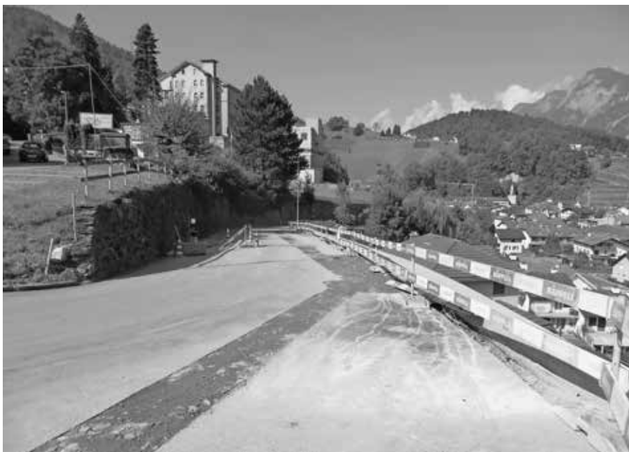
Baustelle Fabrikstrasse: Die erste Etappe (Werkleitungen) wurde im November abgeschlossen, 2017 soll Etappe 2 (Fussgängerschutz) folgen.
