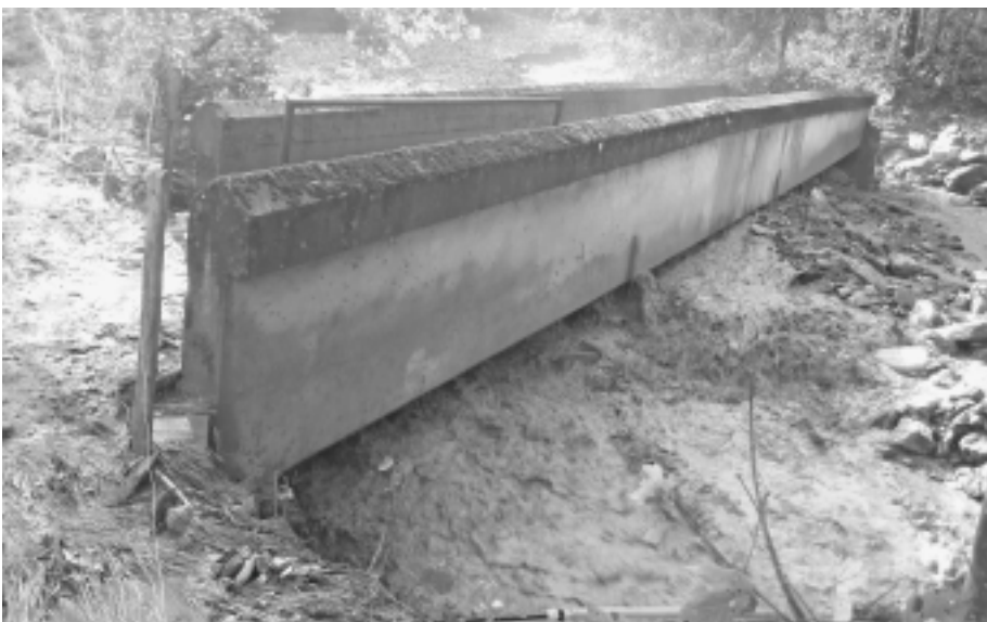
Eingeschottert: Die Zipfbrücke beim Scheibenstand.
