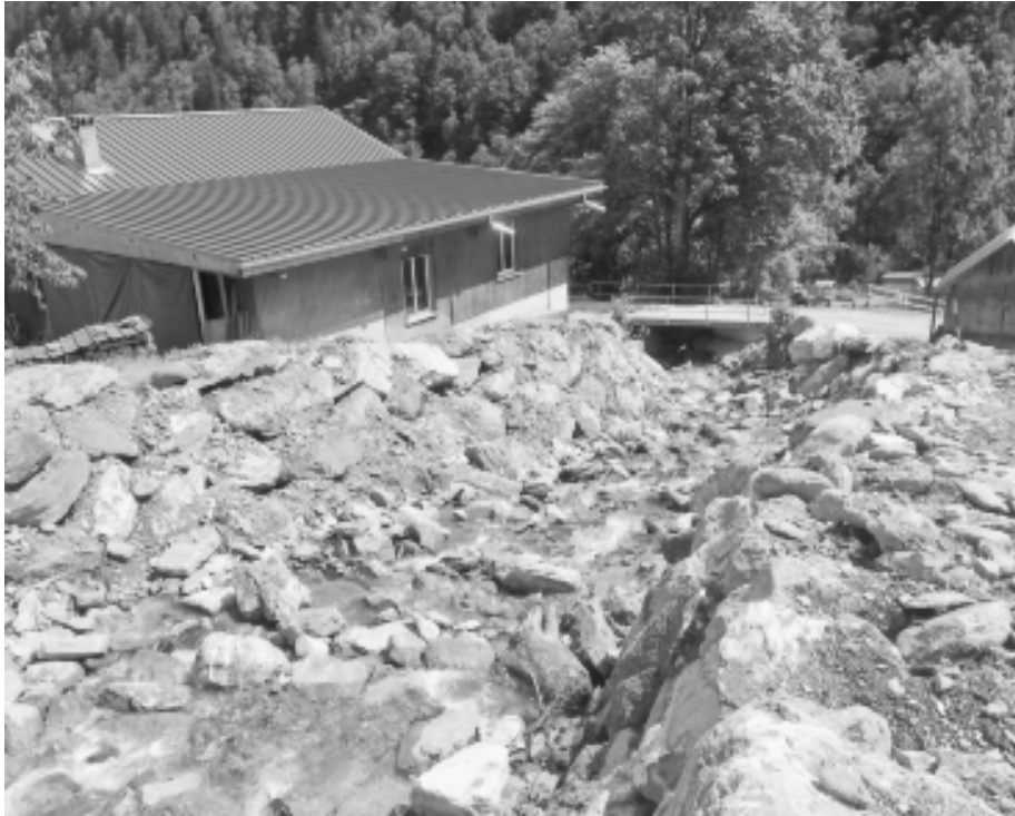
Sorgte erneut für Verwüstungen: Der Mülibach in Schwendi.
