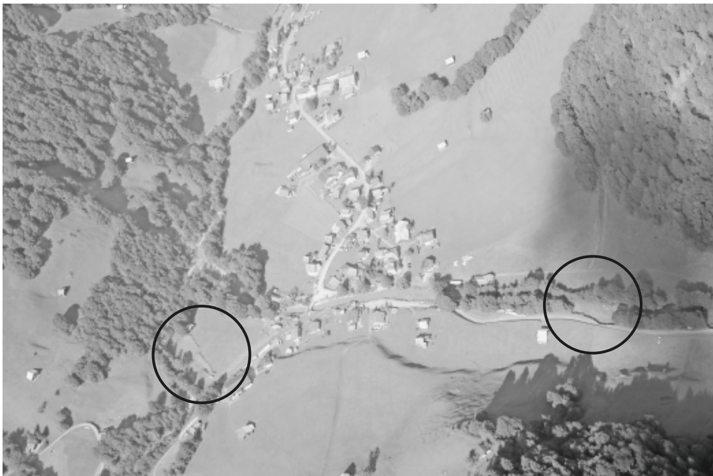
Weisstannen aus der Vogelperspektive: Rechts der Gufelbach mit der beschädigten Gschwendstrasse, links die Deponie auf der Wiese von Willi Aggeler.
