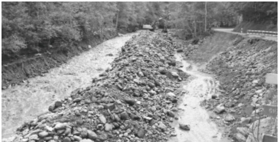
Bachbett der Seez wird ausgebaggert und korrigiert
