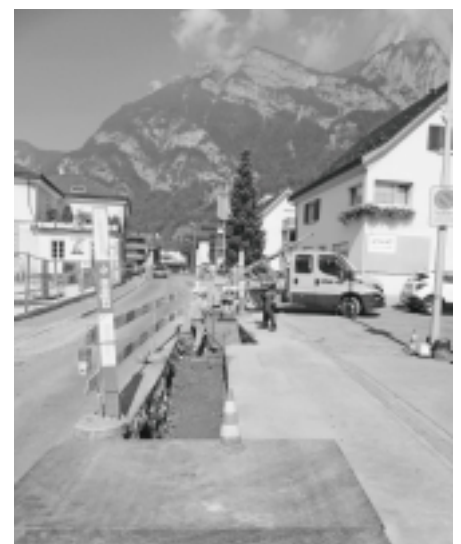
Hausanschlussleitung in der Bahnhofstrasse.
