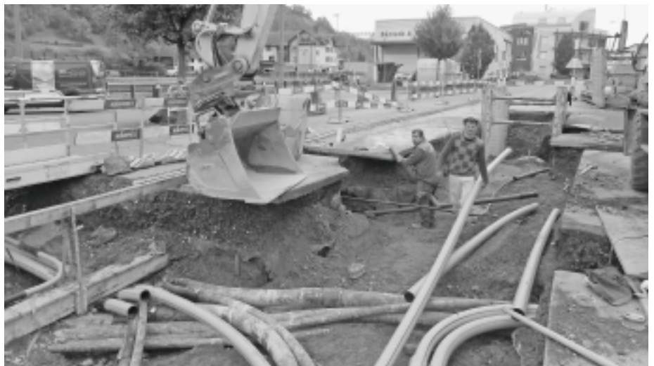
Die Grabarbeiten in der Kreuzung Hofstrasse/Grofstrasse waren nicht einfach bei so vielen Werkleitungen.
