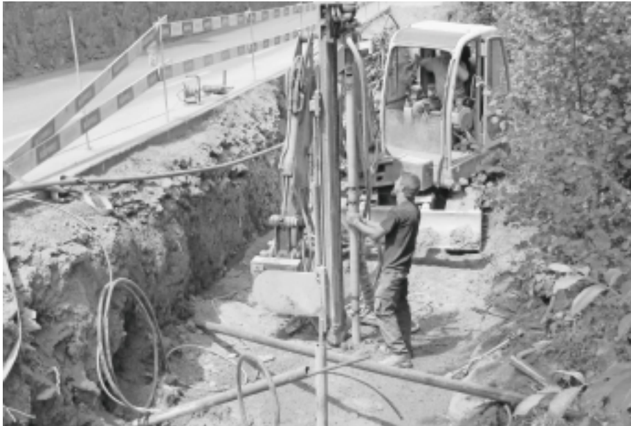
In der Fabrikstrasse werden neue Werkleitungen verlegt.
