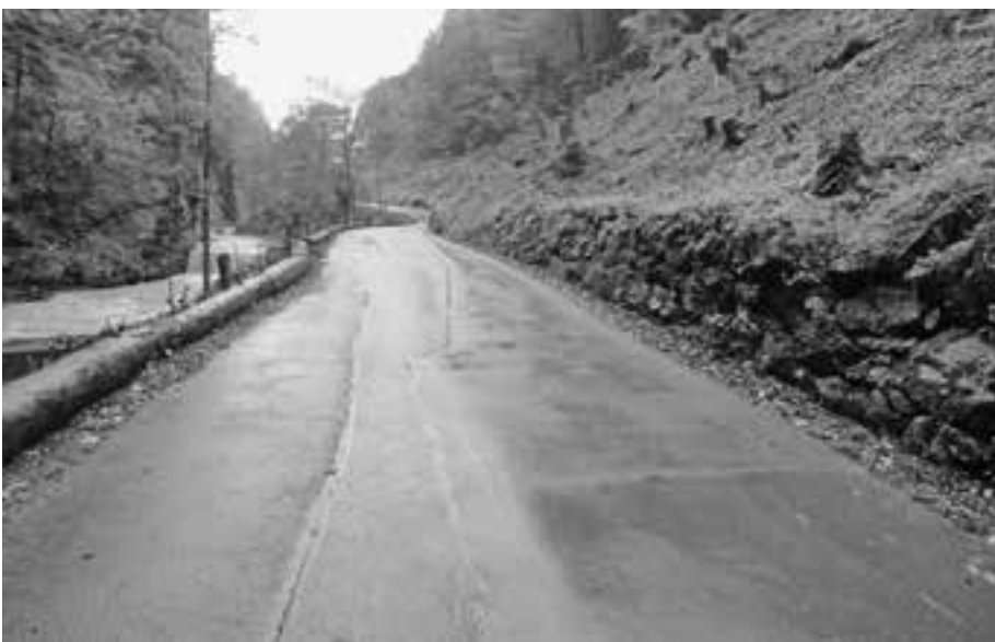
Weisstannerstrasse Esel-Samichlaus im ursprünglichen Zustand
