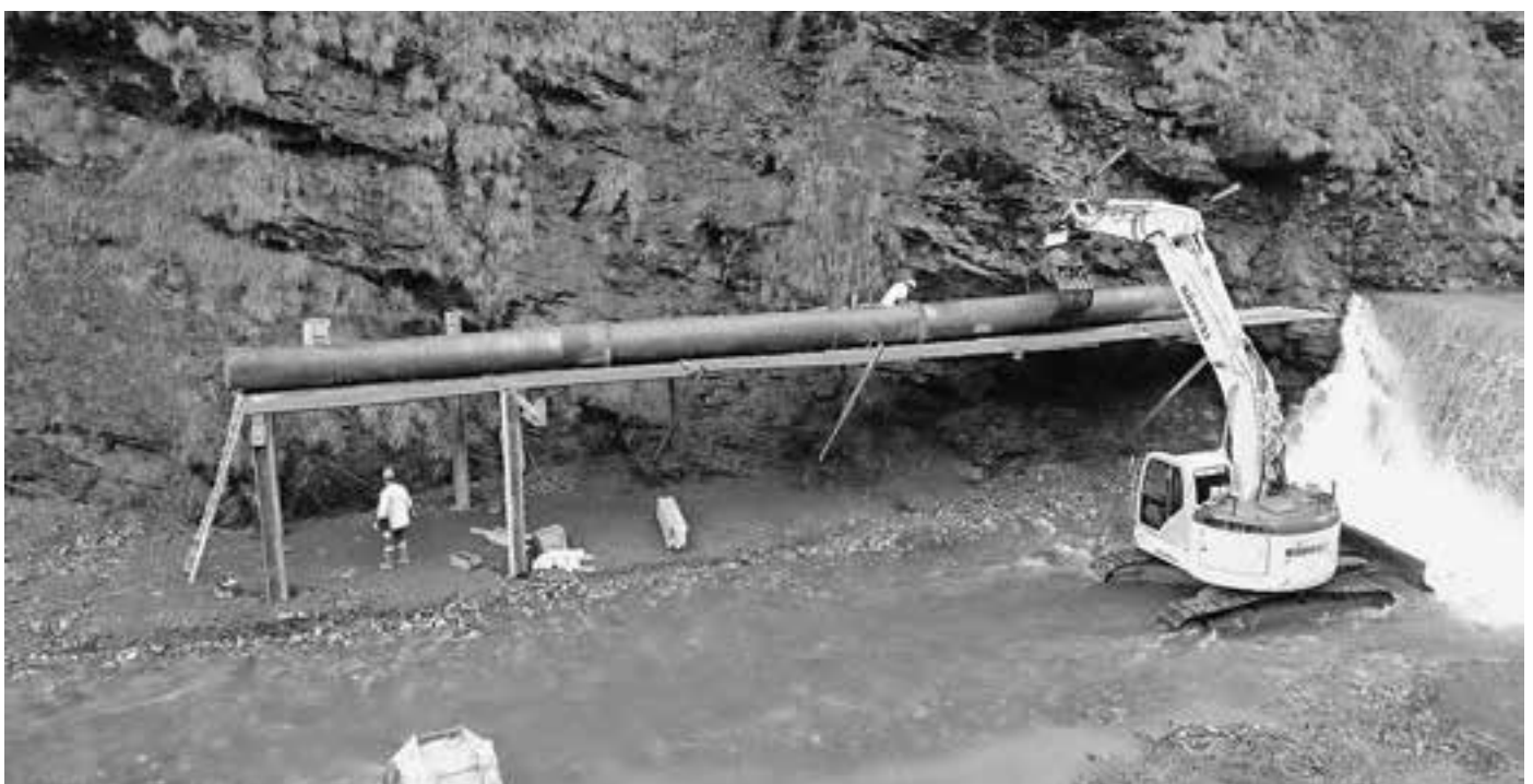
Rückbau der Wasserrohre
