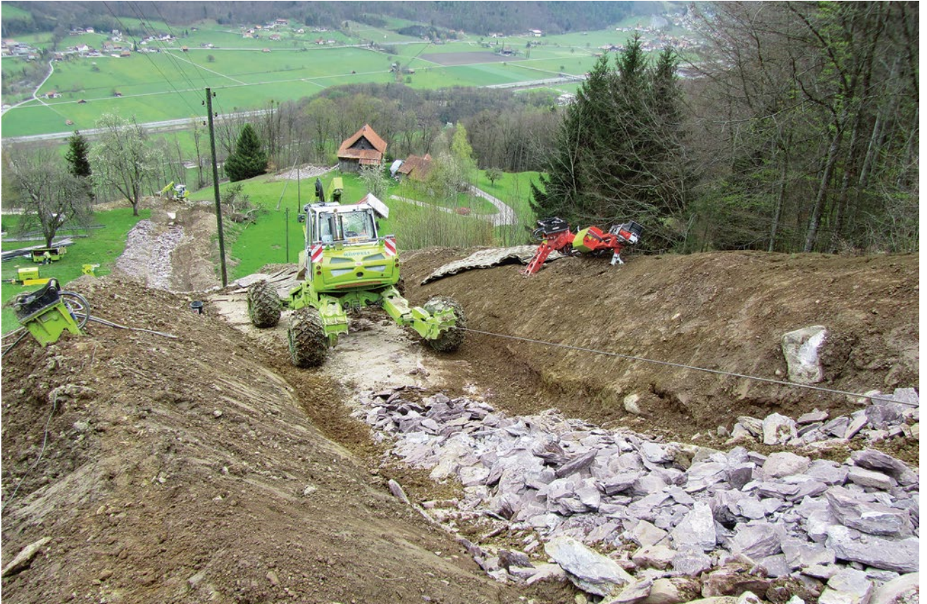
Grabarbeiten im April 2012.
