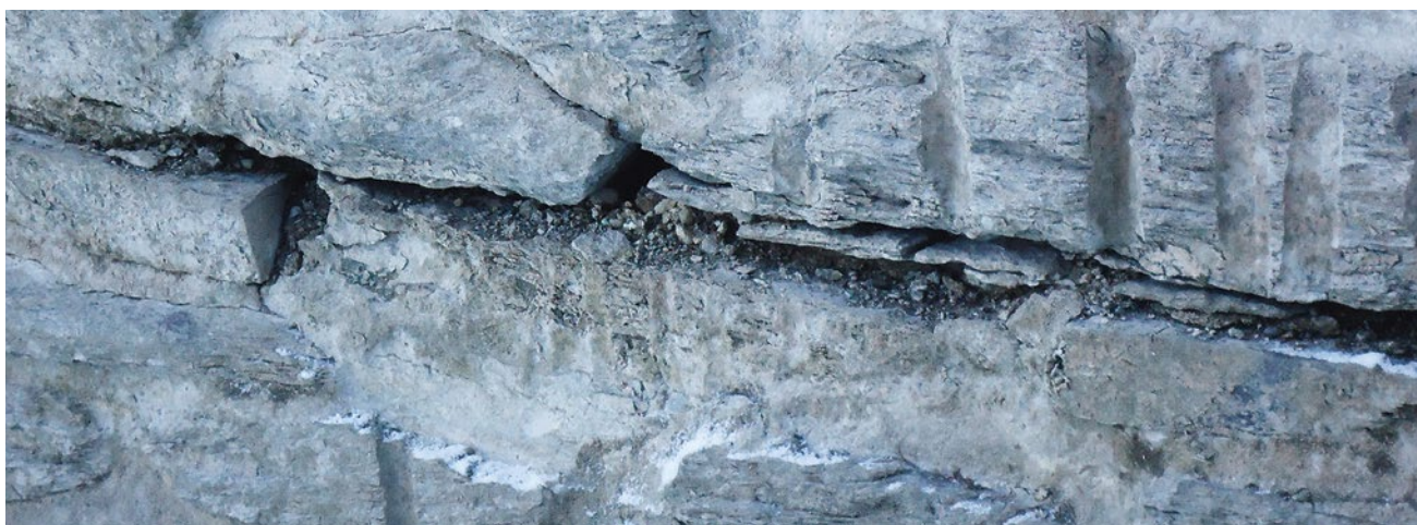
Staumauerschaden See-Innenseite.
