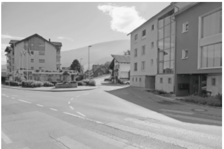
Der Engpass in der Abwasserleitung in der Butzerstrasse wird behoben.
