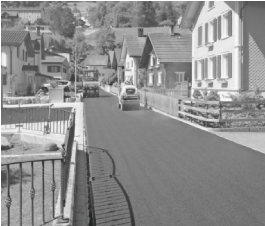
Deckbelagsarbeiten in der Parfanna
