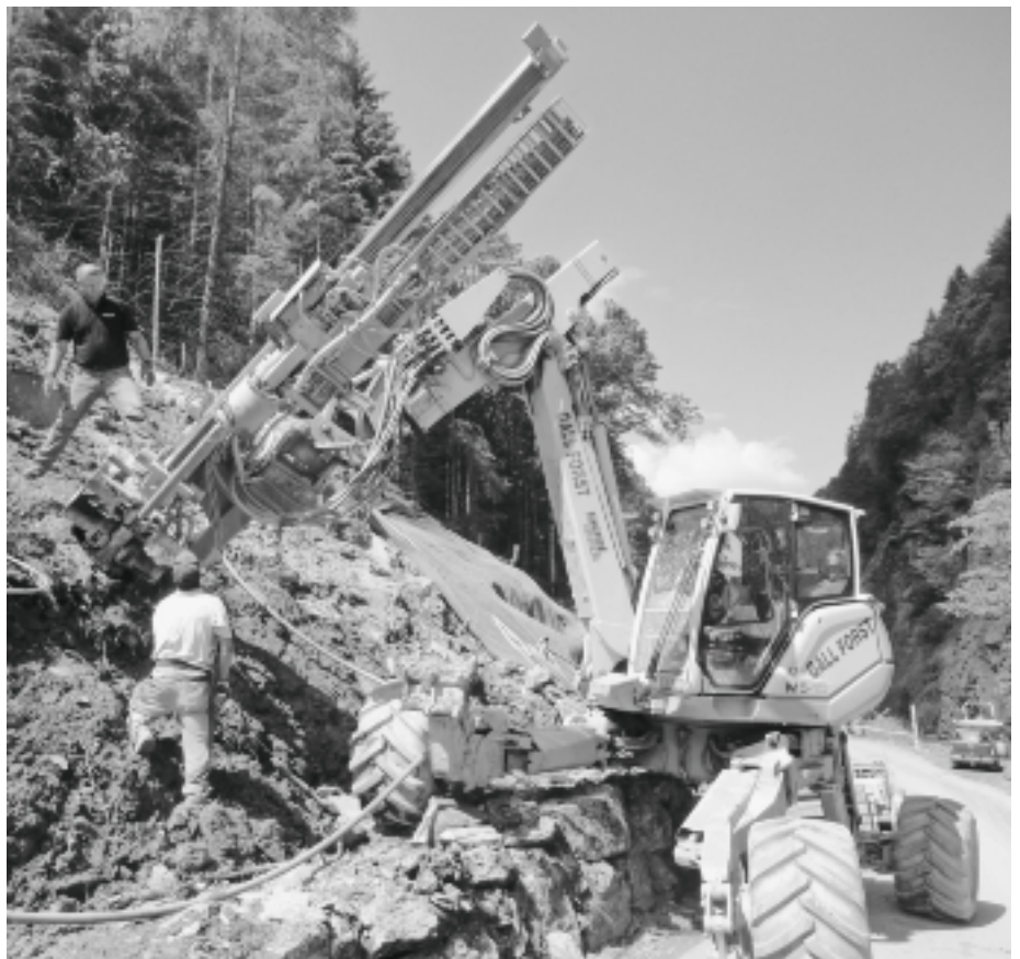
Hangsicherungsarbeiten an der Weisstannerstrasse.
