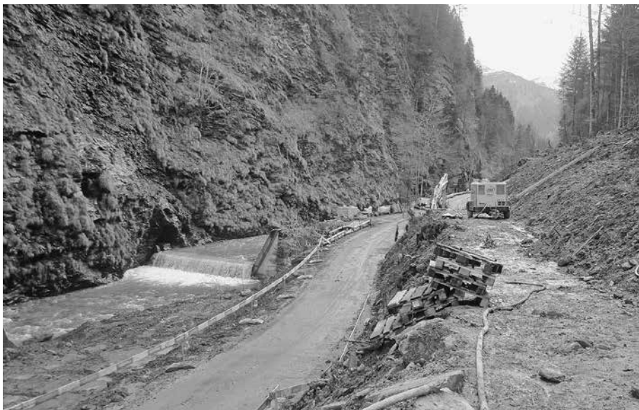
Die Baustelle Esel-Samichlaus sorgt für Verkehrsbehinderungen.
